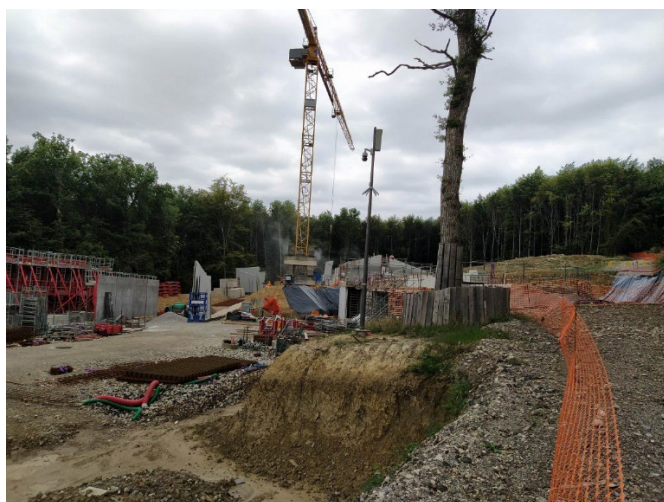
Vue générale du site. Au premier plan, le terrassement pour la fourrière, au second plan le refuge.
